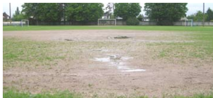
Avant les travaux à la fin de l'automne
