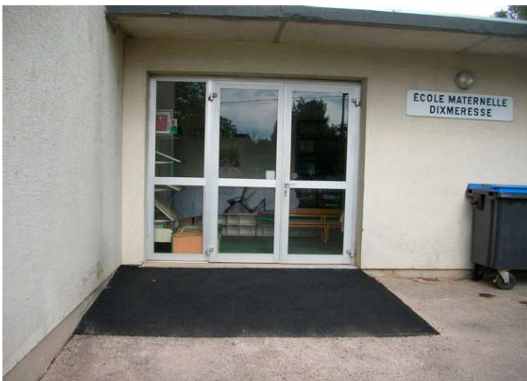
Création de rampes d'accès
