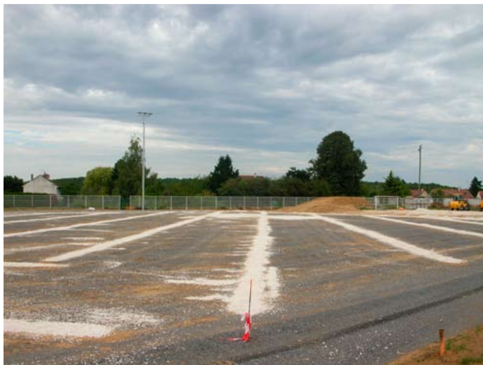
Réalisation du drainage en épi
